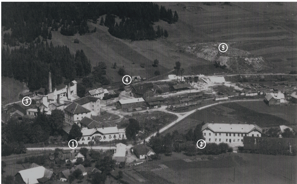
Blick auf das Gipswerk Bruck um 1940. 1 Minnahof, 2 Krumböckhof, 3 Hauptwerk, 4 Stolleneingang, 5 Abraumfeld, oberhalb kreisförmige Einsturzstellen (Pingen/Erdfälle).
