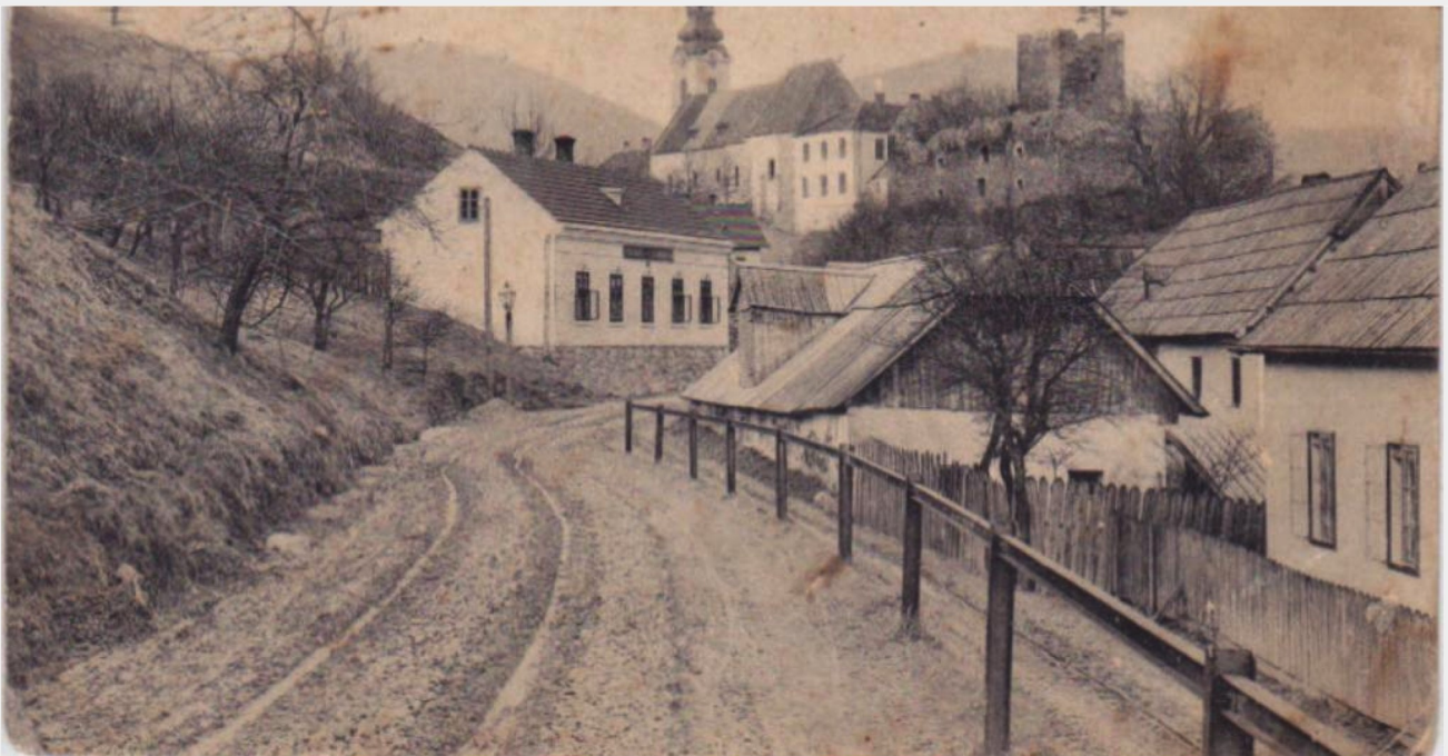
Straßenzustand um 1910, aufgenommen Höhe Neunkirchner Straße 19.
